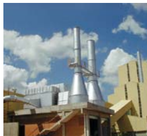
Sandstrahl und Formanlage
