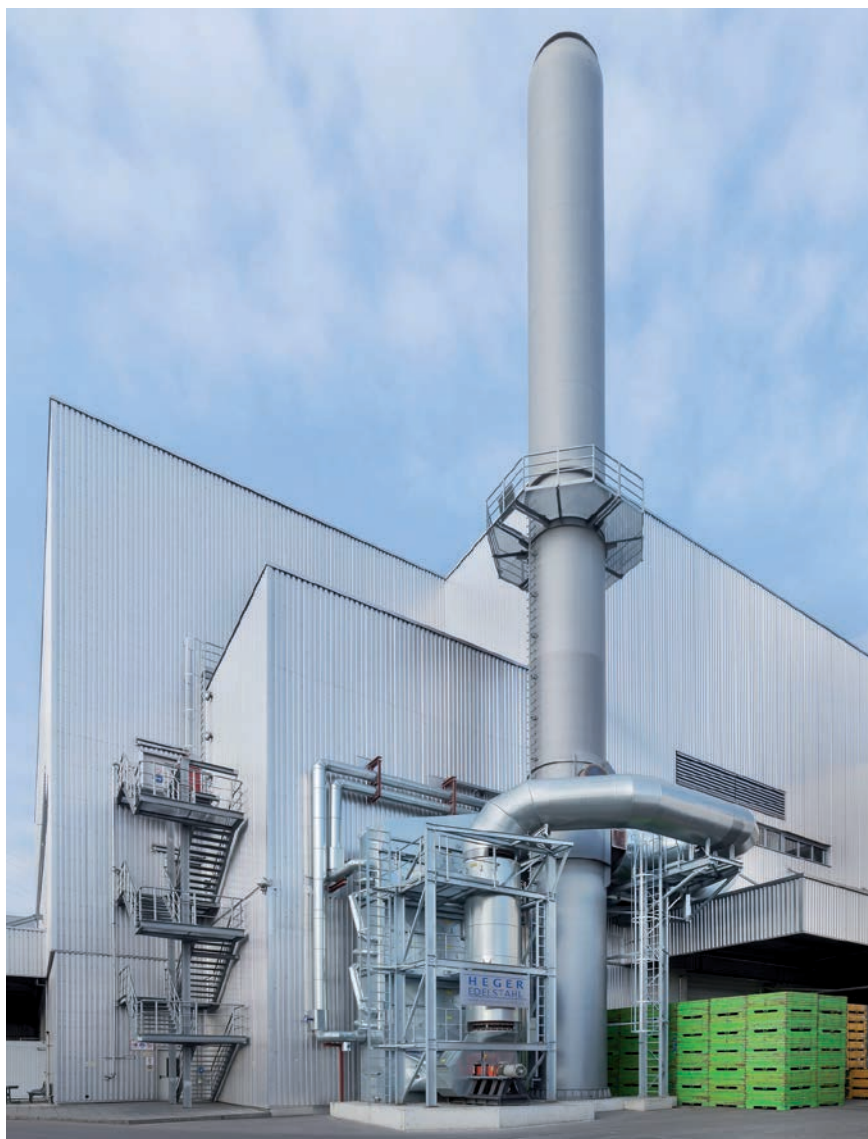
Bild 1: Im Rahmen eines Energie-Einspar-Contractings beauftragte die BMW Group die Unternehmen Siemens, Müller und Gammel Engineering für das Werk in Landshut, ein neues Energiekonzept zu erstellen, das unter anderem die Abwärme aus den Schmelzöfen zur Kälteerzeugung nutzt.
