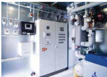
**Bild 3:** Die Kompressoren im Container werden zentral vom Energiesparsystem ES 6 (halblinks, halbhoch im Bild) gesteuert.
