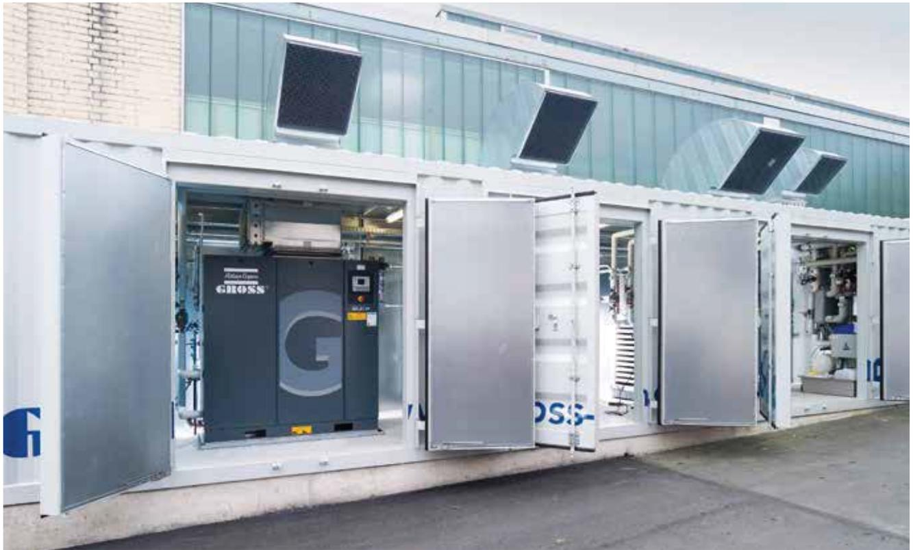
Maschinenhaus unnötig: Der Formenbauer Heck + Becker erzeugt seine Druckluft effizient und platzsparend im Container.
