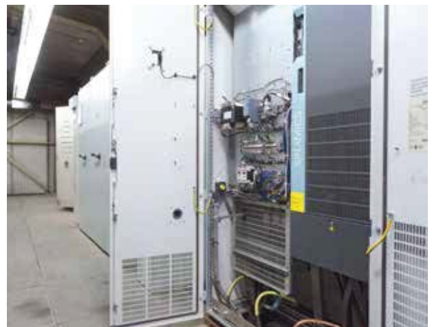
Bild 3: Die Frequenzumrichter Sinamics G120P Cabinet sind speziell auf den Betrieb von Pumpen, Lüftern und Kompressoren optimiert. Zur Optimierung der Betriebsstunden können die redundanten Antriebseinheiten beliebig miteinander verschaltet werden.
