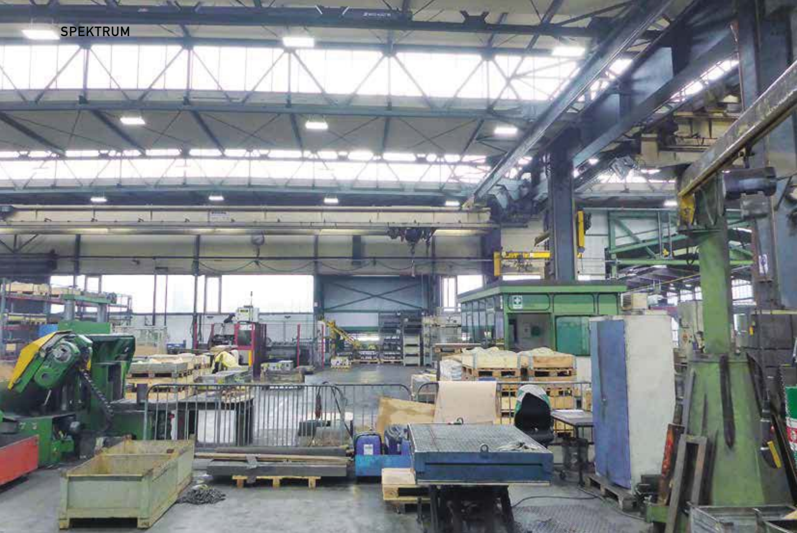
Halle von Gontermann-Peipers in Hain mit neuer LED-Beleuchtung.
