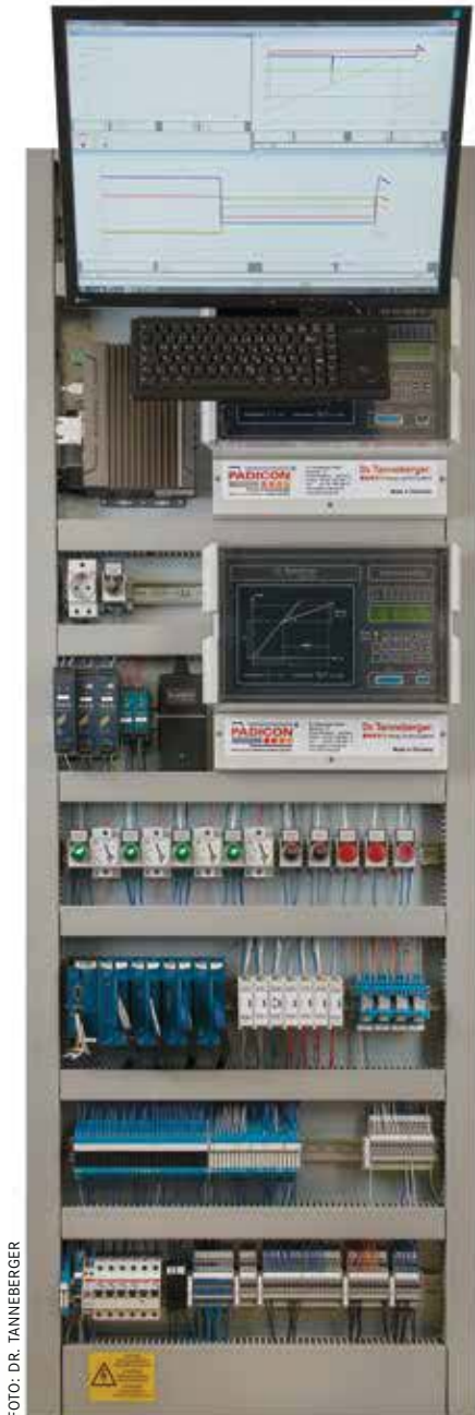
Bild 1: Rittal Schaltschrank: Echtzeitanzeige der Ofenleistungen. Die Vorrangtastatur ermöglicht schnelles Umschalten des Führungsofens ohne Wartezeit.
