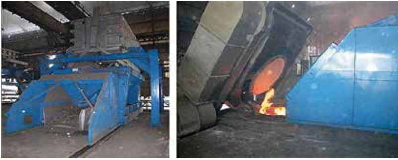
Bild 3: Beladen des Chargierwagens mit Hilfe von bodenentleerbarem Kübel (links) und Andocken des Chargierwagens an die offenstehende Absaughaube (rechts) bei Viraj Profile [5].
