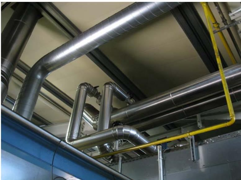
Abbildung 4: Thermalölleitungen für Wasserlacktrocknung
